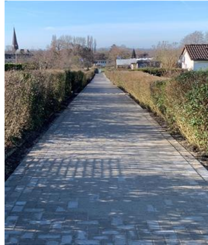
Saniert: ein neu gepflasterter Weg in der Anlage Bochum-Riemke
